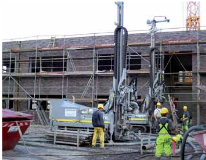
Abb. 3: Mit einer Erdsondenbohrung wurde die Grundlage gelegt für die Nutzung der Erdwärme für Heizung und Klimatisierung.
