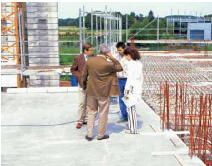
Abb. 2: Baustellenbesprechung: Architekt, Ingenieur und Bauherr vor Ort (im Hintergrund ist die Betonkerntemperierung zu sehen).
